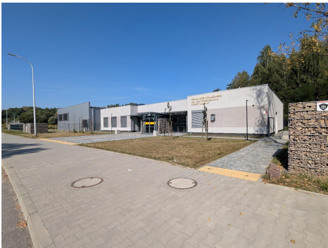
Ryc. 1. Budynek Laboratorium Radioizotopowych Analiz Środowiskowych AGH w Miękini. Fot. J. Pawlyta
